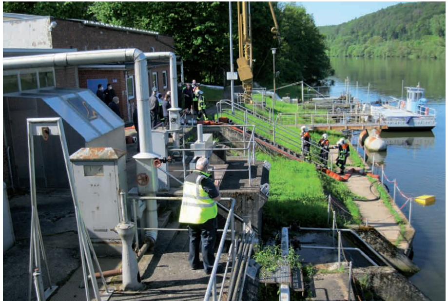
Von der Entnahmestelle am ICO-Hafen musste das Löschwasser über Schlauchleitungen quer durch das ICO unter den Bahngleisen hindurch bis vor das Versandgebäude transportiert werden.
